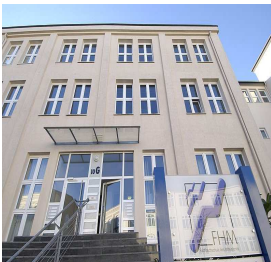
Eingangsbereich der Fachhochschule des Mittelstands in Bielefeld. Fotos: FHM
